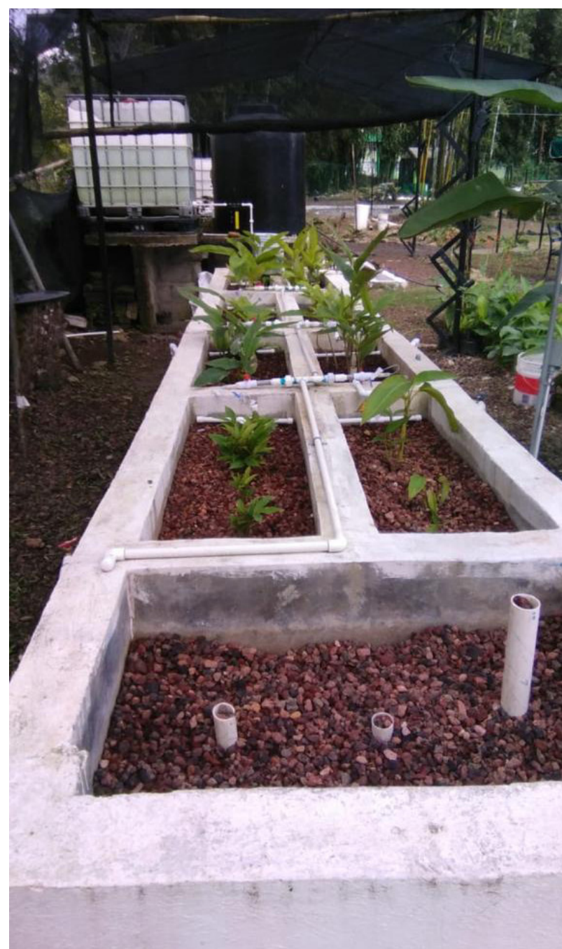
Figura 1. Humedal construido para el tratamiento de agua residual.
