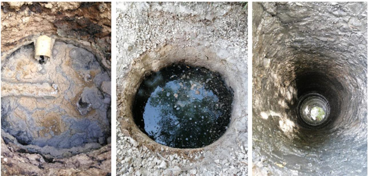
Figura 1. Izquierda: Fotografía de un pozo de absorción saturado e impermeabilizado por grasa y aceites. Central: Fotografía de un pozo absorción saturado e impermeabilizado por lodos espesos. Derecha: Fotografía de un pozo absorción después de un tratamiento de Biodrop Bloque y mantenimiento del equipo de SINBIO. Regresó la absorción del agua en las venas.
