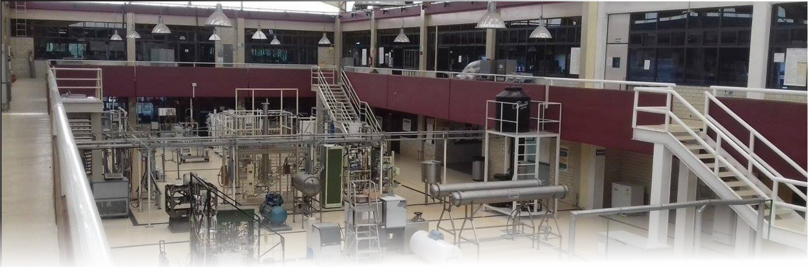
Instalaciones de la Planta Piloto de la UPIBI
