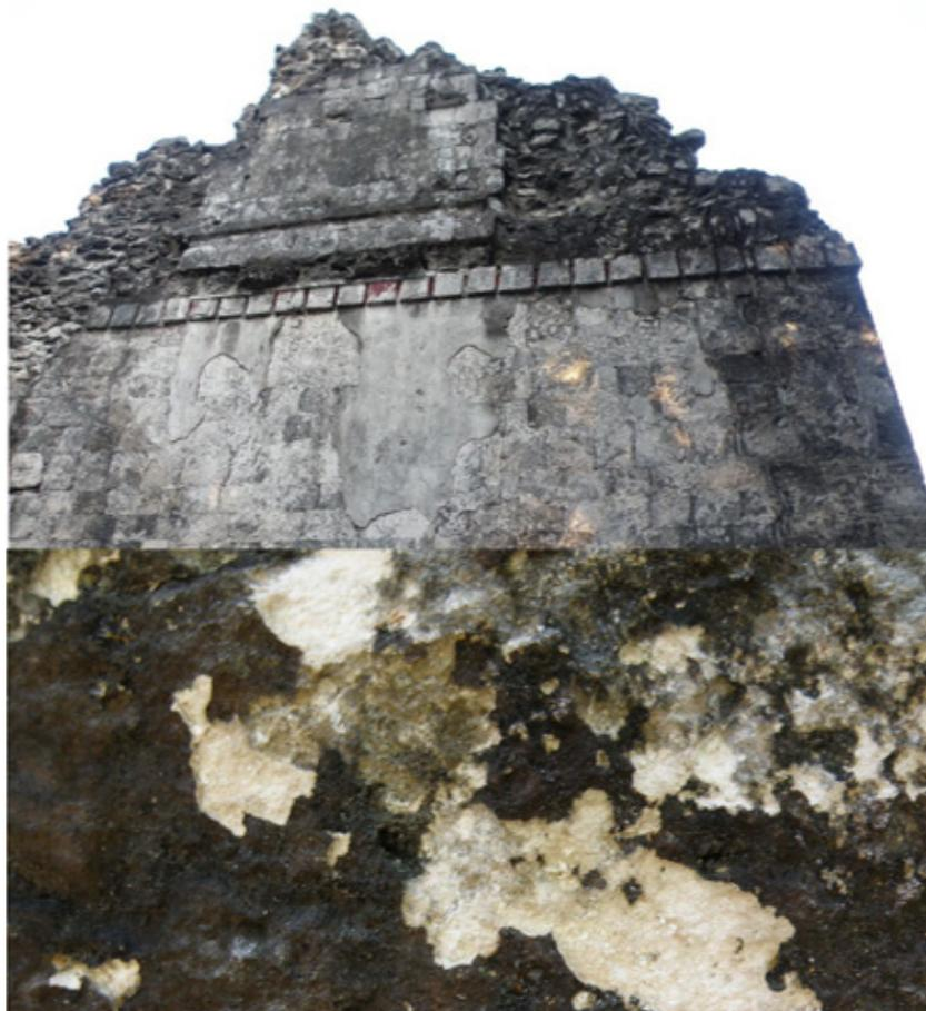
Figura 3. Biopelículas epilíticas (subaereas) desarrolladas sobre sustratos calcáreos, nótese la presencia de la biopelícula como alteración de color negro en superficies expuestas a una permanente radiación. El desprendimiento del biofilm provoca erosión del sustrato calcáreo expuesto (sustrato blanquecino). (Imagen propia).
